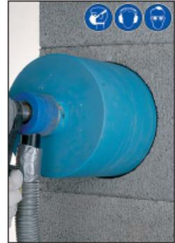
**B4.** Mantelsteinöffnung jetzt mit größerer Bohrkronen vollständig aufbohren **Wichtig: Profilrohr dabei nicht beschädigen oder anbohren!**
