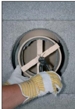
**B6.** Rauchrohrzarge am Profilrohr feströdeln
