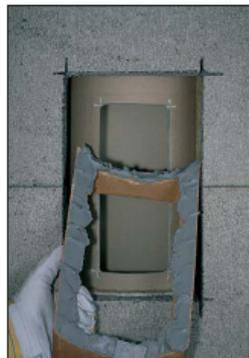
6. Nach reinigen beider Kittflächen Schiedel-Fugenkitt auf die Putztürzarge auftragen
