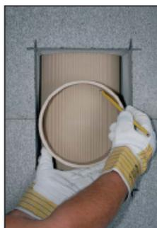
**A4.** Rauchrohrzarge als Schablone verwenden und entlang des inneren Durchmessers anreissen
