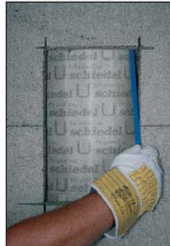
3. Dämmung mittels Sägeblatt entlang der Hinterlüftungskanäle aufschneiden und entfernen
