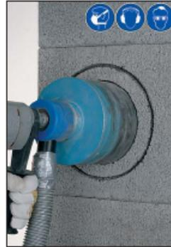
**B3.** Für den inneren Querschnitt, mit kleiner Bohrkronen, vorsichtig durch Mantelstein und Profilrohr bohren
