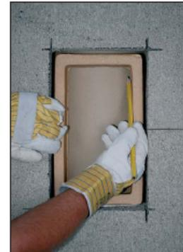
4. Putztürzarge als Schablone verwenden und entlang des inneren Durchmessers anreissen
