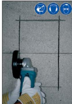
2. Mantelstein mit Winkelschleifer an den Markierungslinien aufschneiden
