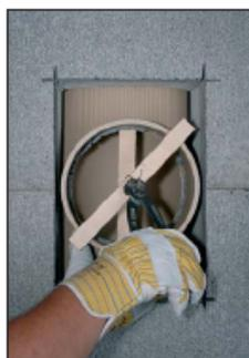
**A12.** Rauchrohrzarge am Profilrohr festrodeln
