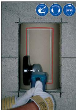
5. Öffnung mit Winkelschleifer herstellen
