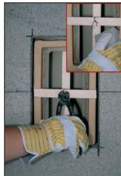
7. Putztürzarge ausmitten und am Schamotterrohr feströdeln. Danach Kittreste vorsichtig mit Schwamm entfernen
